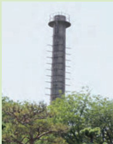
▲香里製造所第3汽罐場煙突 妙見山配水池に永久保存。高さ19.92m、直径2m
