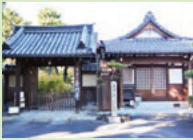
▲普門寺 柿葺屋根の方丈(本堂)は室町期築で国の重要文化財。江戸初期の枯山水の庭を含め境内のほぼ全域が国の名勝。
